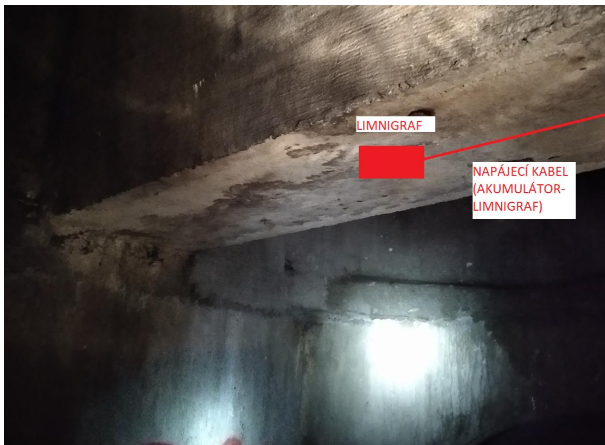
Obr. 4 Na betonové konstrukci nad průtočným profilem štoly bude umístěn limnigraf, který bude vedením propojen jak s akumulátorem elektrické energie, tak s automatickou jednotkou pro přenos dat.
