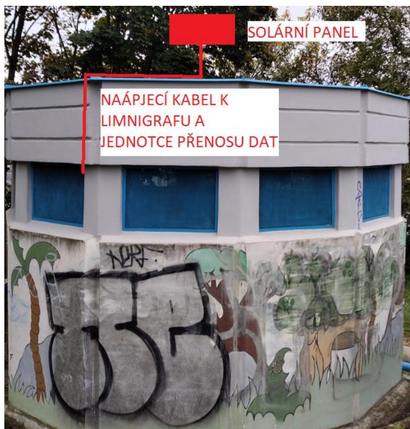
Obr. 2 Solární panel bude ukotven na střechu objektu vstupu do štol. Z něj povede napájecí kabel po střeše budovy, prostoupí ocelovou mříží okna a dále povede na podlahu objektu, kde bude umístěn akumulátor elektrické energie a automatická jednotka pro přenos dat.
